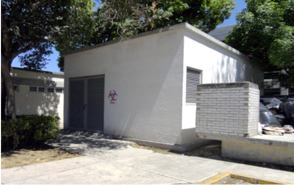
Figura 4.5. El almacén de RPBI se ubica entre el bioterio y la UBIMED, al fondo del estacionamiento sur, a un costado de la artesa donde se concentran los desechos de aserrín.
